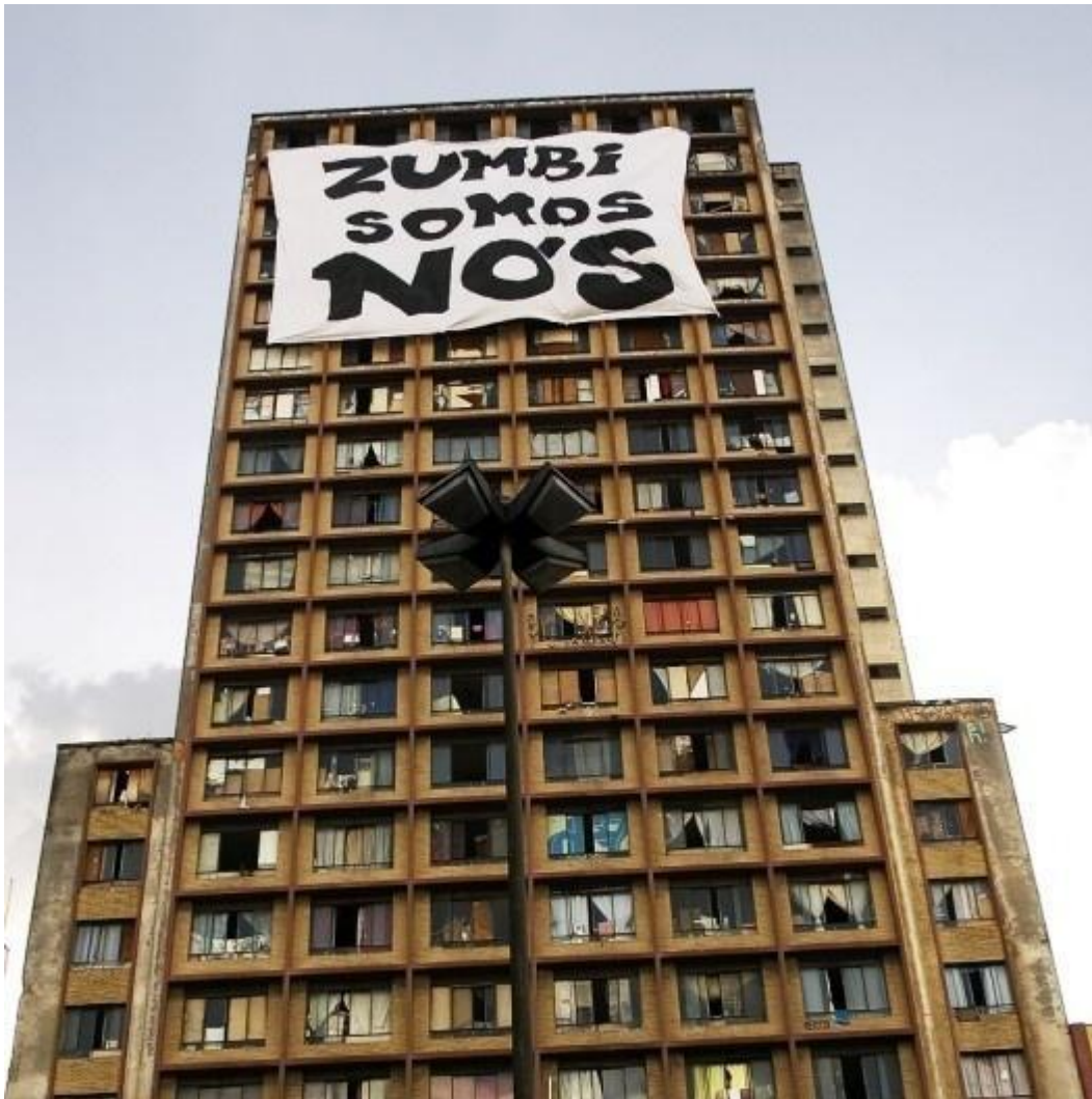
Figura 1: Coletivo Frente Três de Fevereiro: Bandeira “Zumbi Somos Nós” na Ocupação Prestes Maia, São Paulo (2006). Fotografia de Julia Valiengo. Fonte: < https://tinyurl.com/5fttxndh >. Acesso 31 mar 2024.
