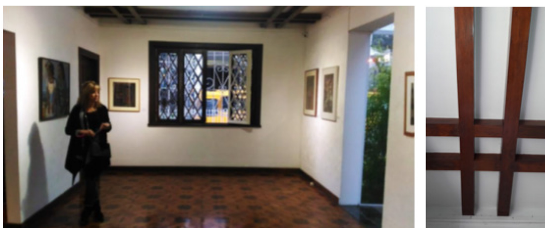
Figura 5: Espaço expositivo do MGV com detalhe das vigas no teto. Fonte: o autor, 2016.
