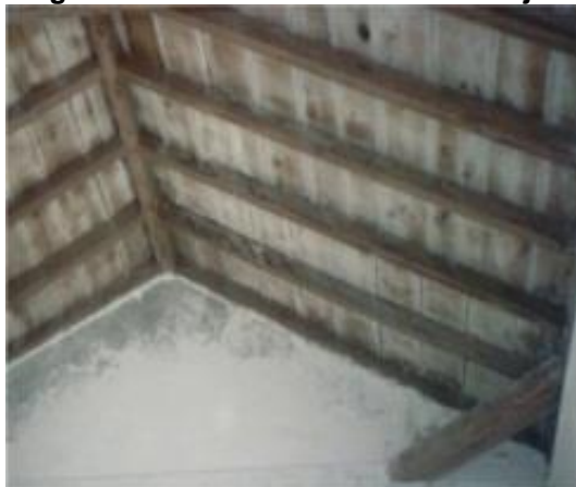
Figura 5: Foto de la cubierta de alfarjes
