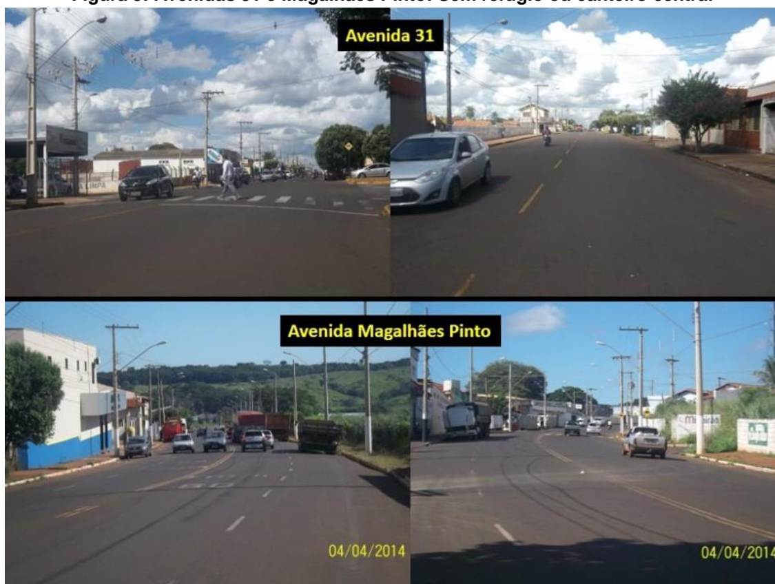
Figura 9: Avenidas 31 e Magalhaes Pinto: Sem refúgio ou canteiro central
