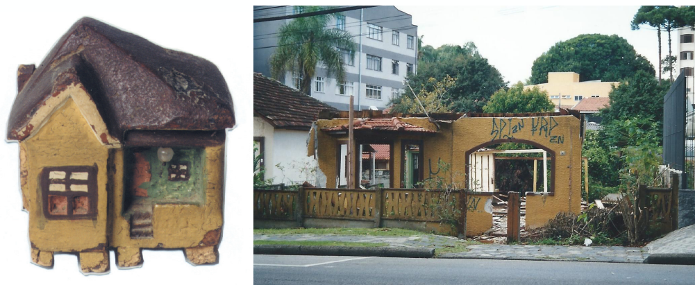
Figura 3 - Comparativo entre a menor replica da casa e a demolição da casa. 15
