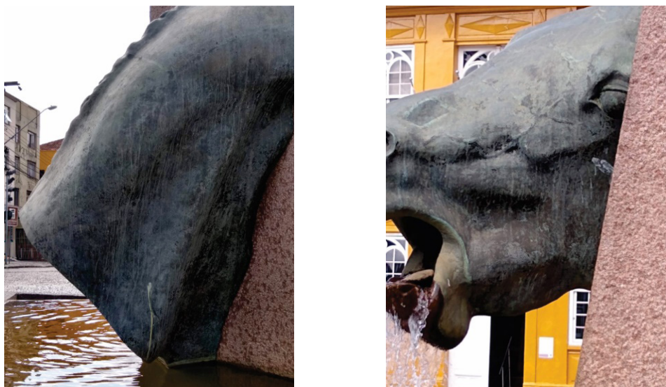
Figura 8 – Manchas. Linhas causadas por chuva mancham todo o bronze. Novembro de 2019
