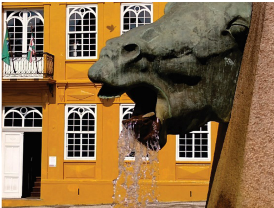
Figura 7 – Presença de sujeira e outros danos. Crostas de sujeira e fuligem acumuladas na volumetria da escultura de bronze. No bronze em contato com a rocha há sinal de rejunte da argamassa. Curitiba setembro de 2019
