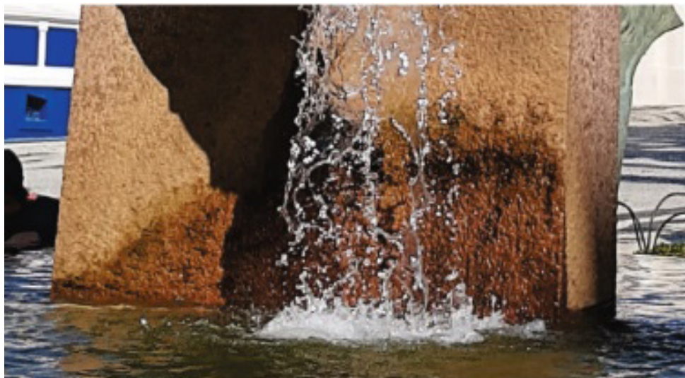
Figura 11 – Umidade. Umidade na base e, provavelmente, oxidação. Curitiba novembro de 2019
