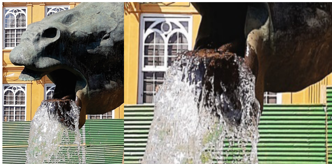
Figura 10 – Boca: Degradação causada pelo contato com a água. Curitiba setembro de 2019
