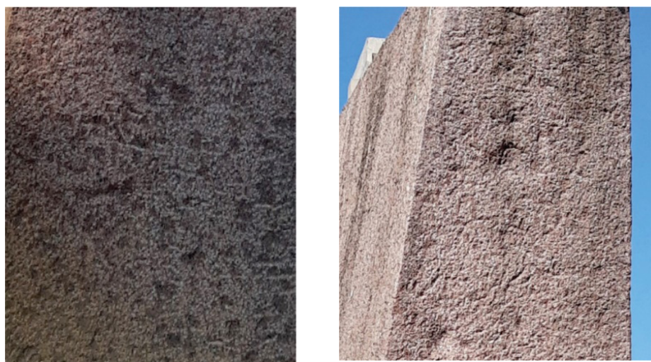
Figuras 12 e 13 – Relevos. Nos relevos da rocha escondem-se depósitos de sujidade. Setembro de 2019
