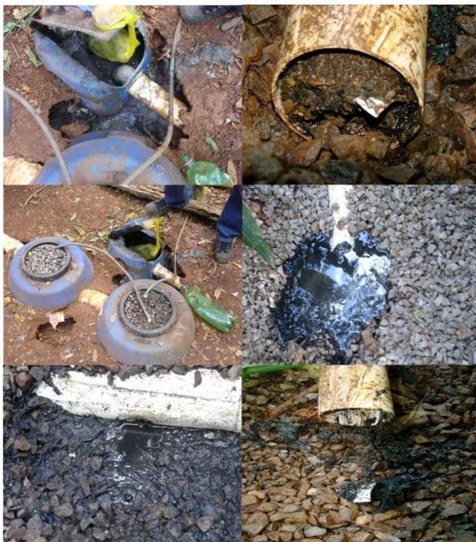
Figura 7: Fotos mostrando diversos entupimentos detectados.
