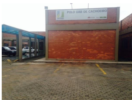
Figura 1 - Fachada do Pólo UAB
