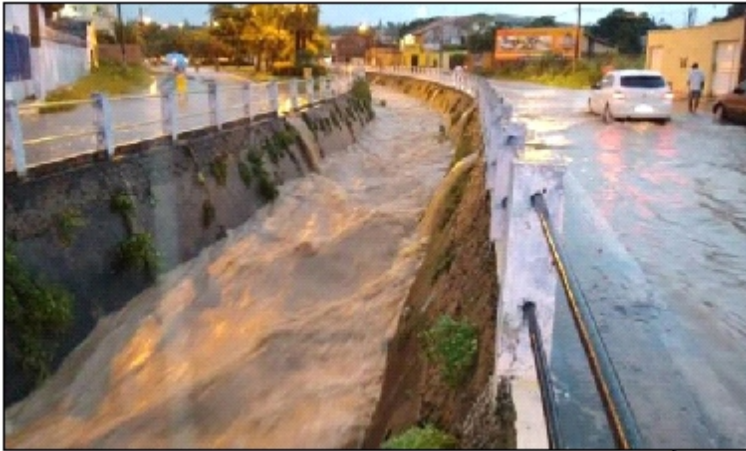
Figura 6 - Canalização da microbacia hidrográfica do riacho Agua Fria
