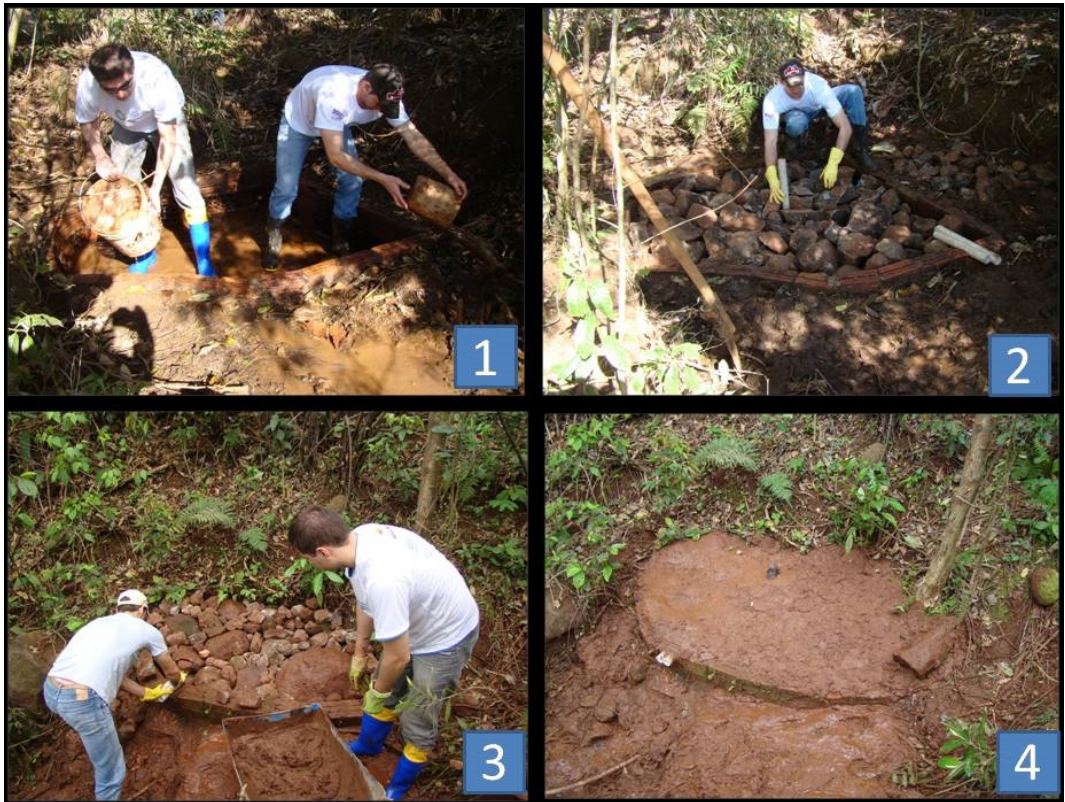
Figura 3. Processo de proteção e recuperação de nascentes. A- Retirada de material orgânico e limpeza da nascente; B- Distribuição da pedra-rachão e instalação da tubulação; C- Impermeabilização da nascente com solo-cimento; D- Nascente protegida com a técnica do solo-cimento.
