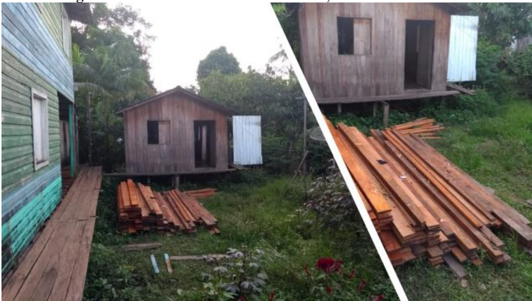
Figura 5 - Madeiras a ser utilizadas na construção de uma nova moradia.
