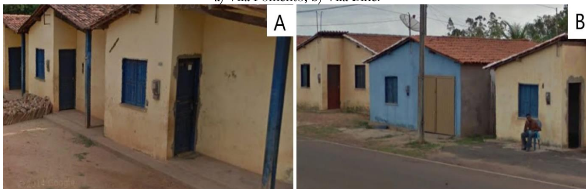
Figura 6 - Vista dos conjuntos habitacionais construídos com recursos do FNHIS em Codó/MA (2019). a) Vila Fomento; b) Vila Biné.
