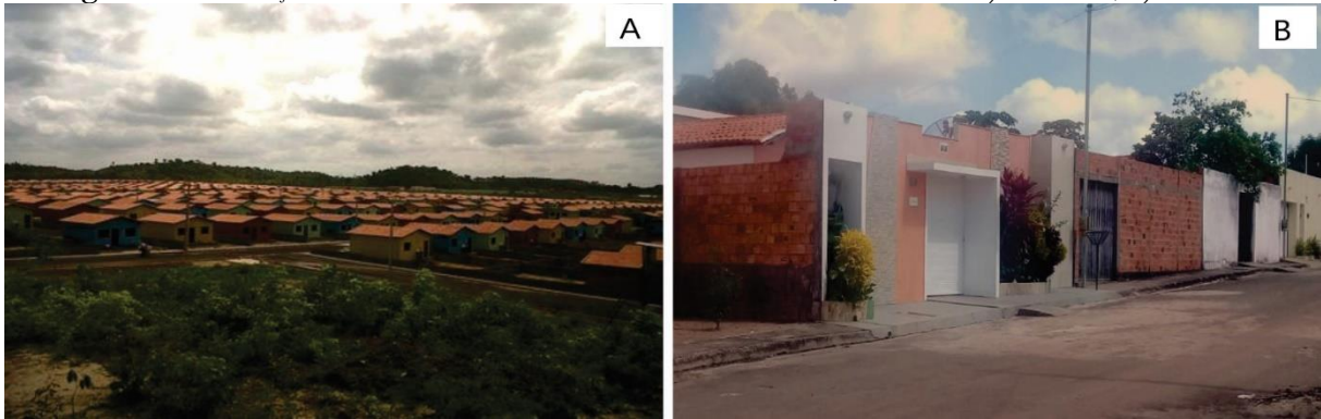
Figura 9 - Habitações do PMCMV no Residencial da Trizidela, em Codó. a) em 2013; b) em 2019.
