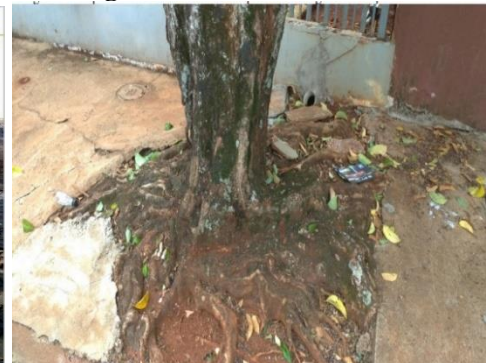
Figura 7 - falta de acessibilidade
