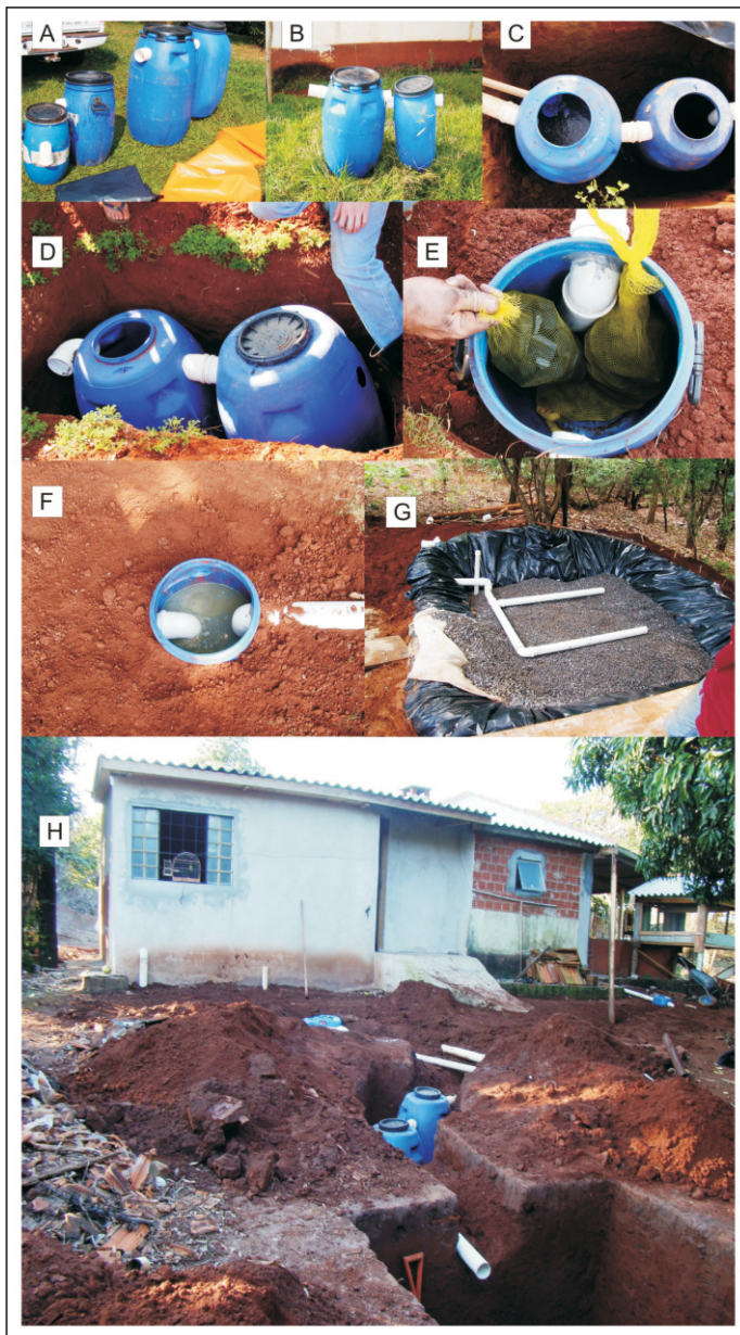
Figura 3 – Algumas etapas de montagem de uma ETEZR: A) bombonas plásticas que foram utilizadas para fossa séptica, caixa de lavanderia e caixa de gordura; B) bombonas utilizadas para fossa séptica; C-D) fossa séptica instalada; D) detalhe da caixa de lavanderia instalada com carvão vegetal; E) detalhe da caixa de gordura em funcionamento; E) detalhe do cano de escoamento subsuperficial antes de ser coberto por brita; H) detalhe de uma das residências antes do final da montagem da ETZR, mostrando todas as bombonas instaladas.
