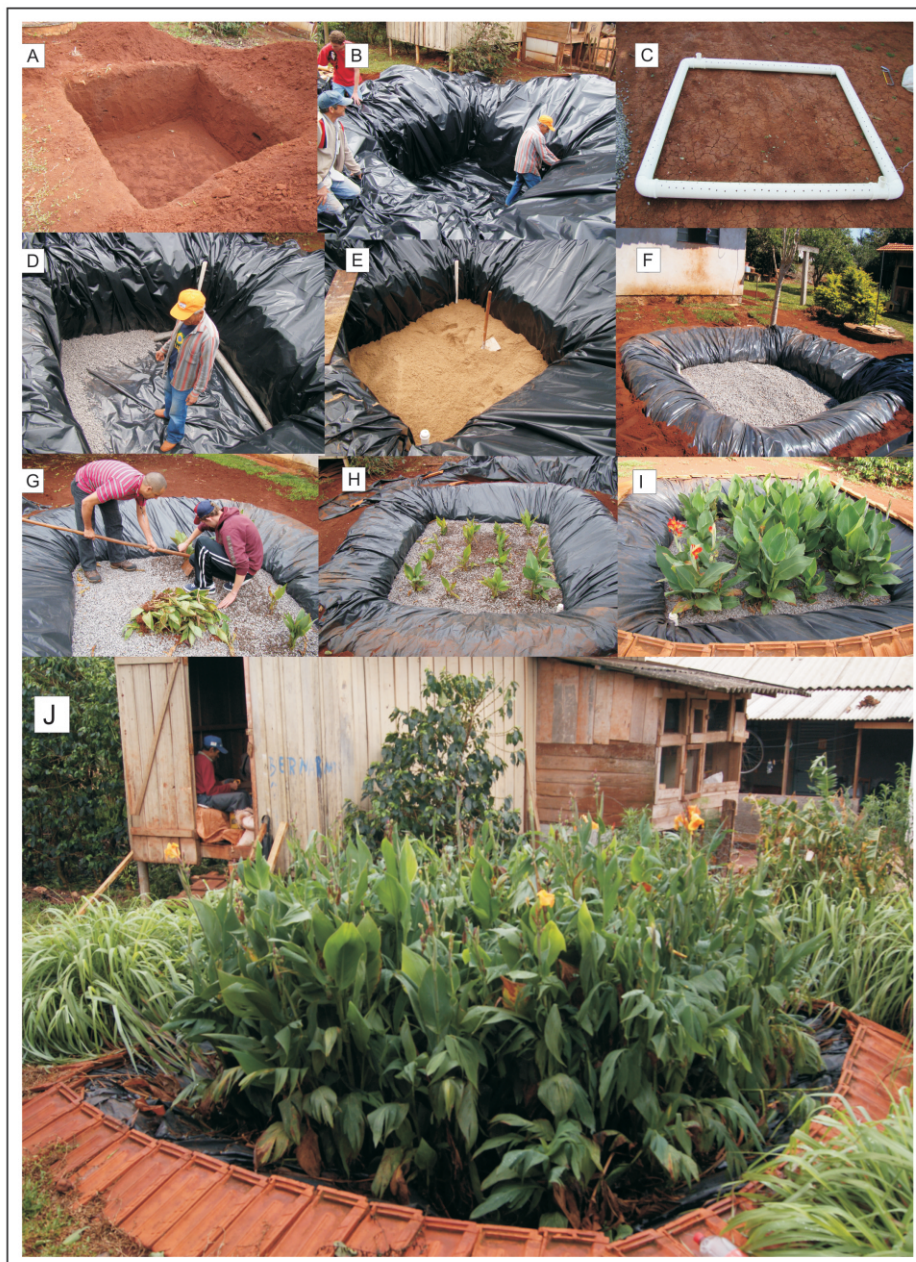
Figura 2 – Algumas das etapas de montagem de uma ETEZR: A) escavação de uma área de 4m 2 por 1m de profundidade; B) impermeabilização com lona plástica e colocação da estrutura coletora; C) canos de PVC perfurados para coleta de efluente no fundo da estação; D) encobrimento dos canos perfurados com brita; E) cobertura de areia ~50cm; F) cobertura com brita ~50cm; G-I) plantio e desenvolvimento de Canna indica ; J) estação de tratamento após 6 meses. Fonte: acervo dos autores
