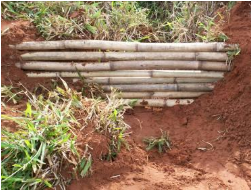
Figura 04 – Barramento com bambus para controle de erosão linear.
