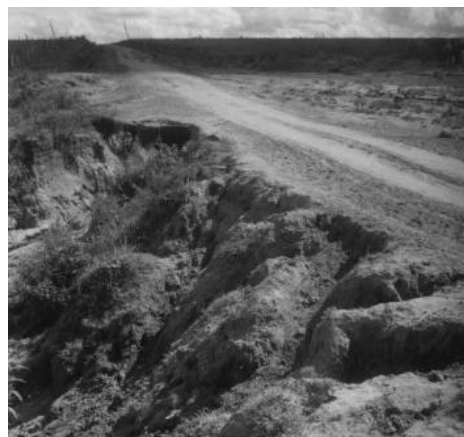
Figura 02 – Ravinamentos às margens de estrada rural. Município de Rancharia-SP.
