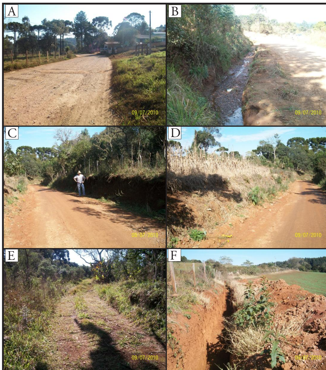
Figura 3: Características das estradas na BHRP. Em A, estrada primária (seção 1); em B, ravina com 120 m de comprimento (seção 2); em C, barranco em repouso (seção 3); em D, barranco com vegetação exposição a luz do sol (seção 3); em E, caminho interno com vegetação (seção 3); em F, medida antrópica de controle de sedimento (seção 4).
